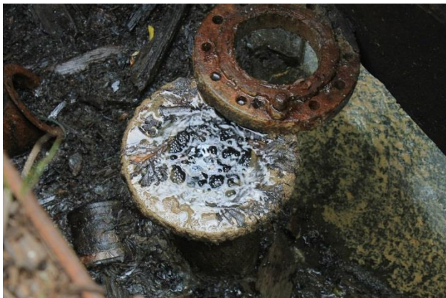
Рис. А.2.26. - Скважина Р-3 роторного бурения: не законсервирована, оголовок открыт, наблюдается интенсивное газирование 8
