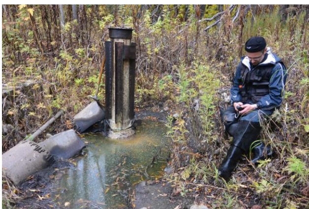
Рис. А.2.28. - Скважина Р-2 роторного бурения: законсервирована, однако наблюдается сочение из-под оголовка и бензиновая пленка на поверхности земли в радиусе 1,5 м
