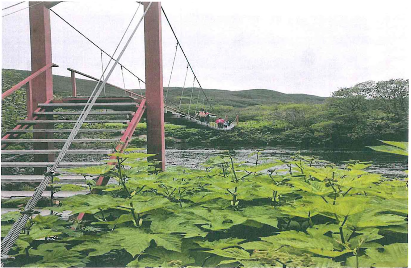
2. Подвесной пешеходный мост через реку Озерная. Фото Н.С. Умецкая
