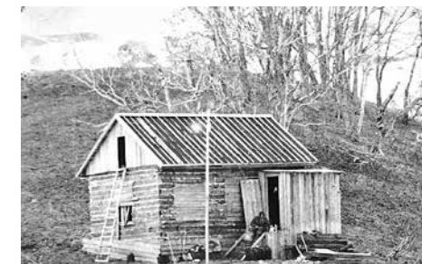
25. Начало строительства дома в Долине гейзеров. Строится дом вулканологов, 1972 г. Фото В. М. Сугрובה.
