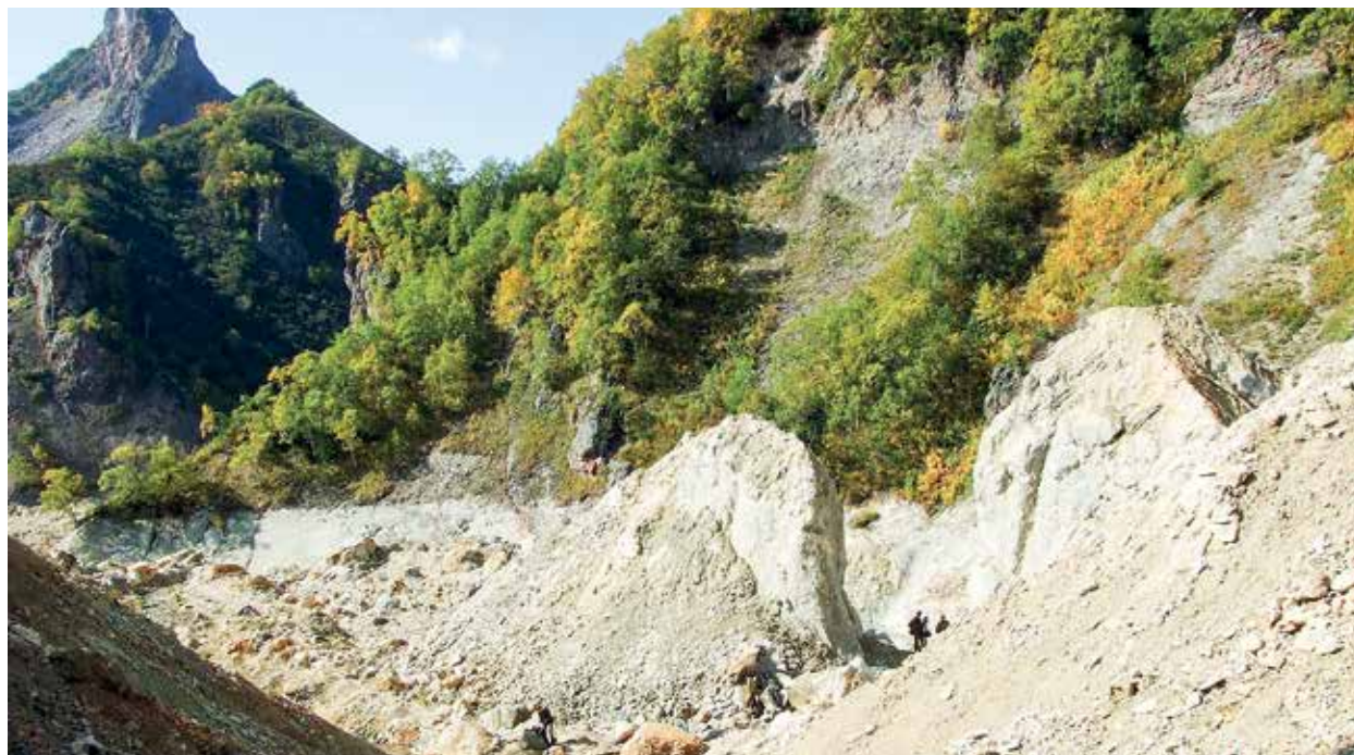
99. Триумфальные Ворота после оползня. Фото В. Ф. Уразметова, 2009.
