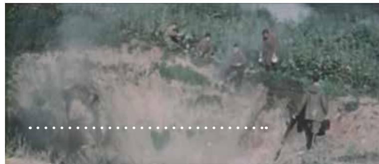
264-267. Печь в воронке, верхняя (современный Голубой котёл). Киносъёмка 1949 г. 328 Пунктиром показан современный уровень воды.
